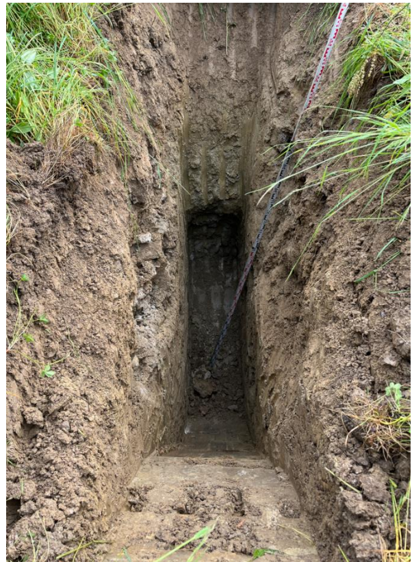
Tranchée de reconnaissance à la pelle mécanique T7446-02
