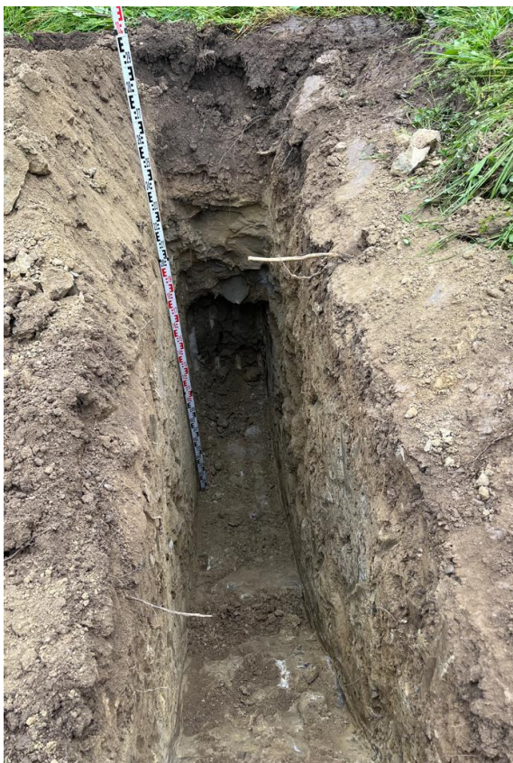
Tranchée de reconnaissance à la pelle mécanique T7446-03
