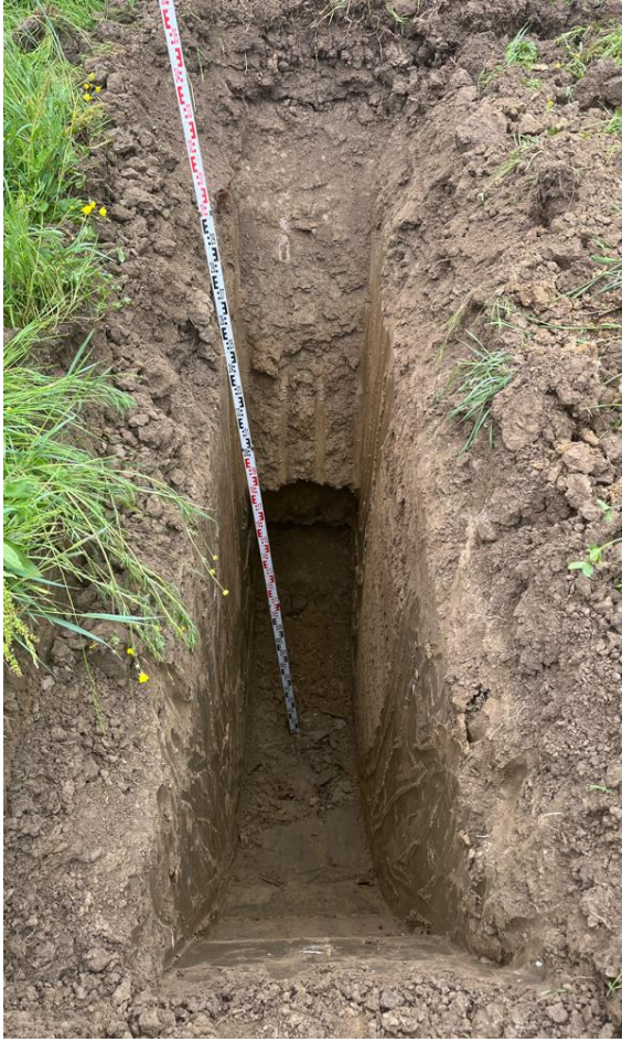
Tranchée de reconnaissance à la pelle mécanique T7446-05
