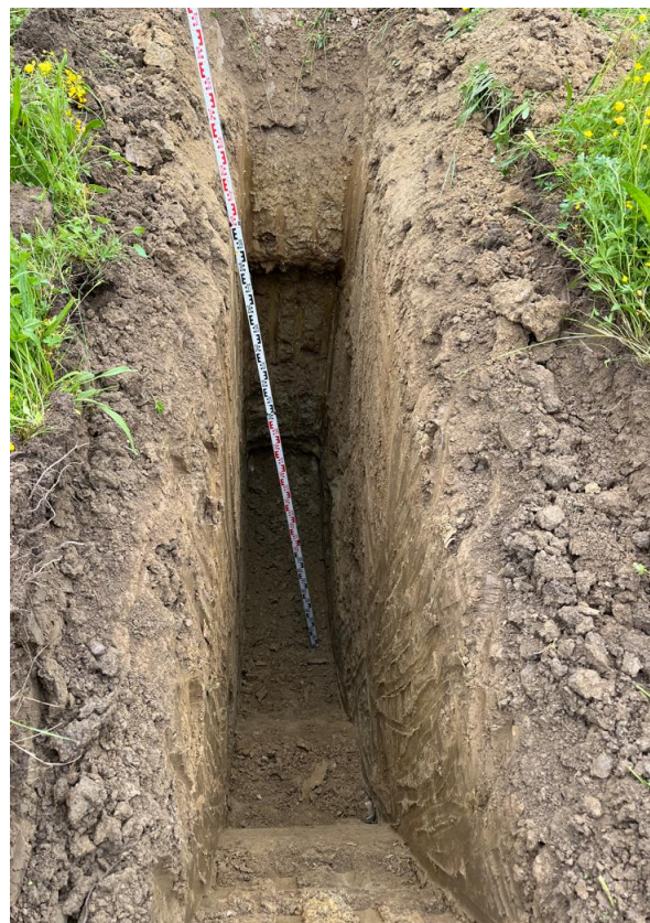
Tranchée de reconnaissance à la pelle mécanique T7446-04
