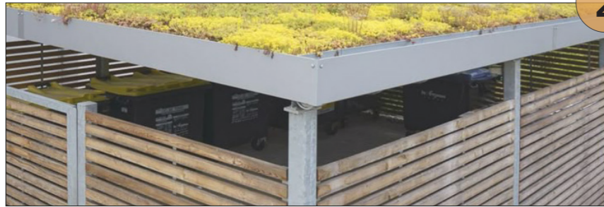
Couvert à vélos avec toitures végétalisées
