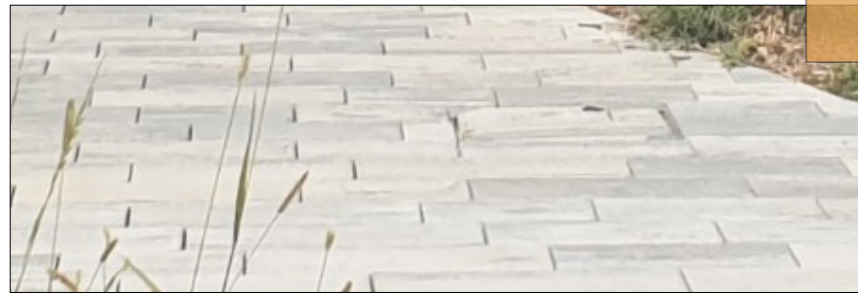
Cheminements piétons/vélos en pavés filtrants
