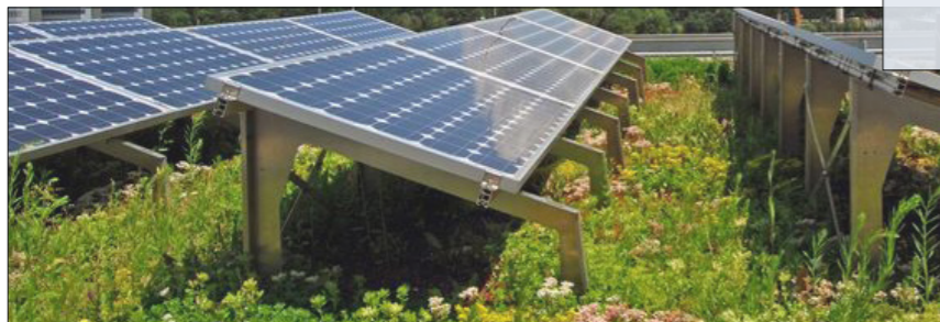
Toitures végétalisées extensives
