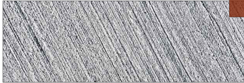
Escaliers béton finition balayé et murets en béton
