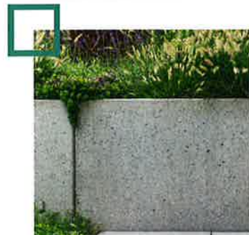
Muret en béton préfabri- qué. Elément en équerre type «Roztec midi sablés» de Créabéton.
