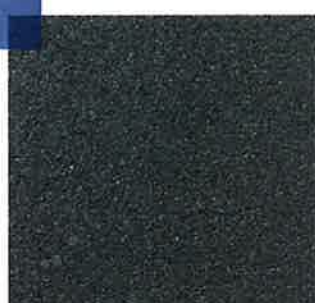
Surface en enrobé bitumineux imperméable
