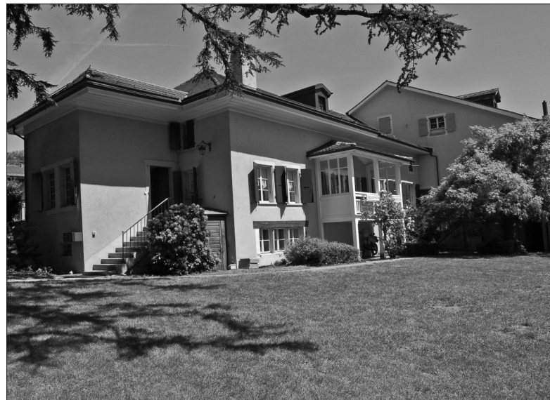
Après le 1 er étage, les combles ont été aménagés pour l'accueil des enfants.
