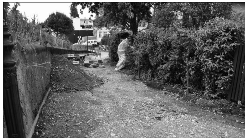
Chemin, tuyaux, tout est à neuf.
