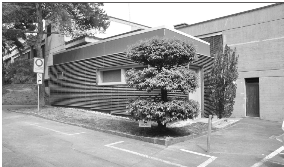
La sous-station St-Maire.
