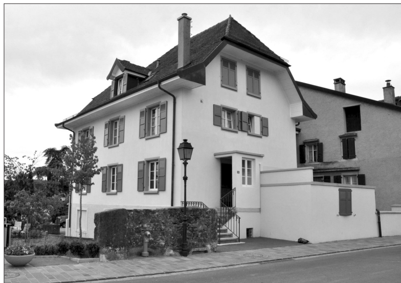
Bordinette 16: les quatre appartements sont refaits.
