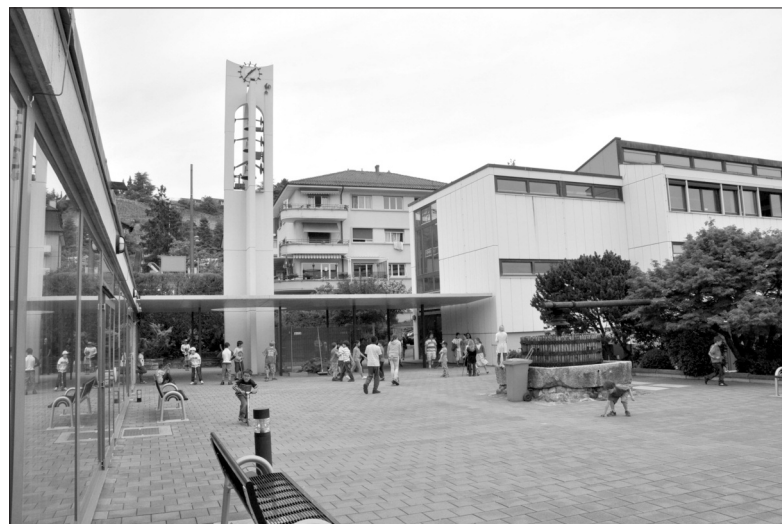
Le nouveau préau couvert relie le collège à la salle de gym.
