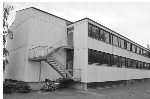
Escalier de secours pour l'école.
