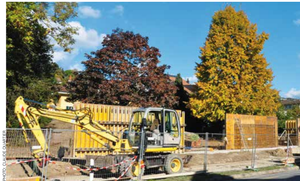
La construction du mur pour remplacer la haie de thuyas disparues.
