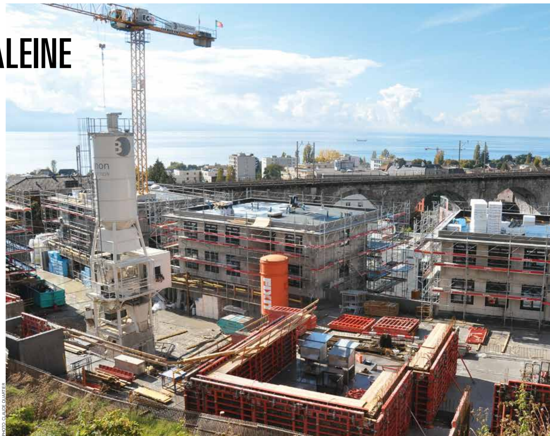
Les bâtiments de la deuxième et troisième rangées en constructions et tout n'est pas encore résolu.
