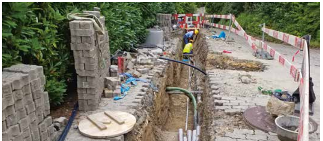
Le perpétuel entretien des canalisations et des routes.
