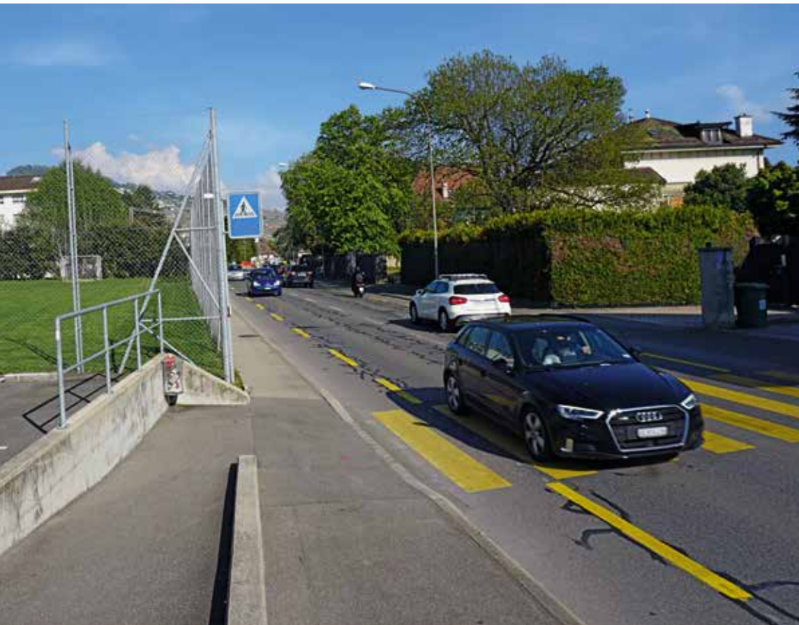
Route du Lac: un revêtement phonoabsorbant est prévu.
