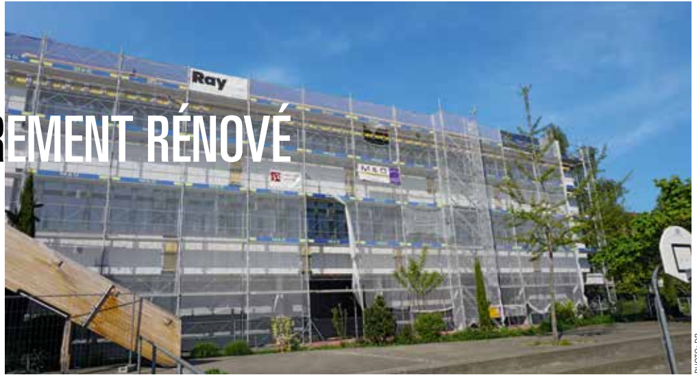
Derrière les échafaudages bientôt enlevés, un collège tout renové!
